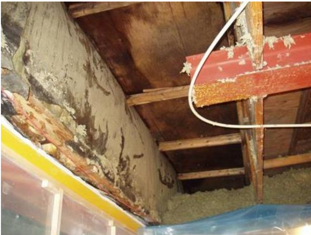
Figur 2 Ett fuktskadat yttertak i ett badhus där taket är frilagt från insidan.
