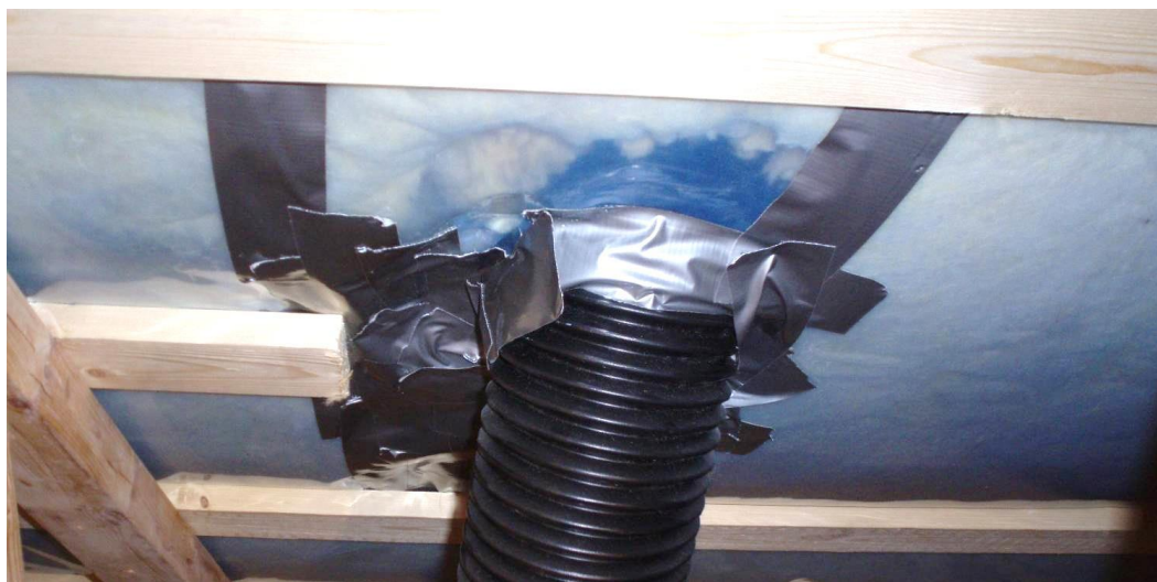
Figur 3 Fuktkonvektion, fuktig inneluft som läcker in i ytterväggar och yttertak via lufttätheter, är ett problem som kan förekomma i badhus. Lufttäta lösningar där exempelvis otäta genomföringar undviks är ett viktigt steg för att undvika skador.
