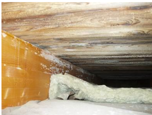
Figur 7 Kondensutfall på ett underlagstak.
