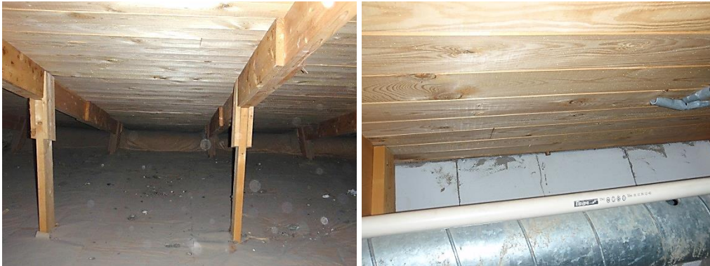
Figur 13 Lufttätad vindskonstruktion försedd med tilluft.
