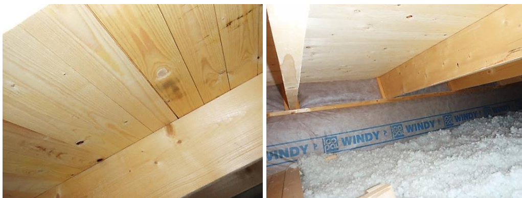
Figur 12 Visar oskadad råspont och takstolar i renoverad vindskonstruktion. Renoveringen utfördes 2009.
